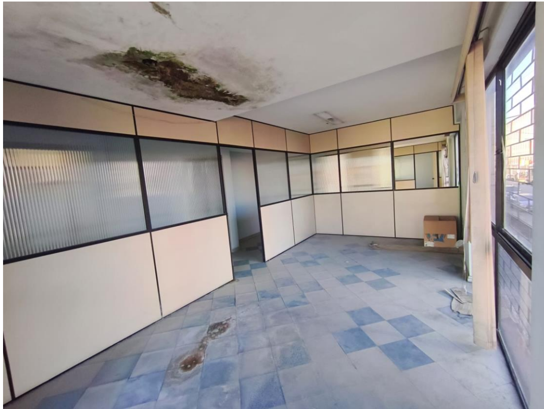
Foto 14: Sala interna Fonte: Carvalho Lira Engenharia, 2026
