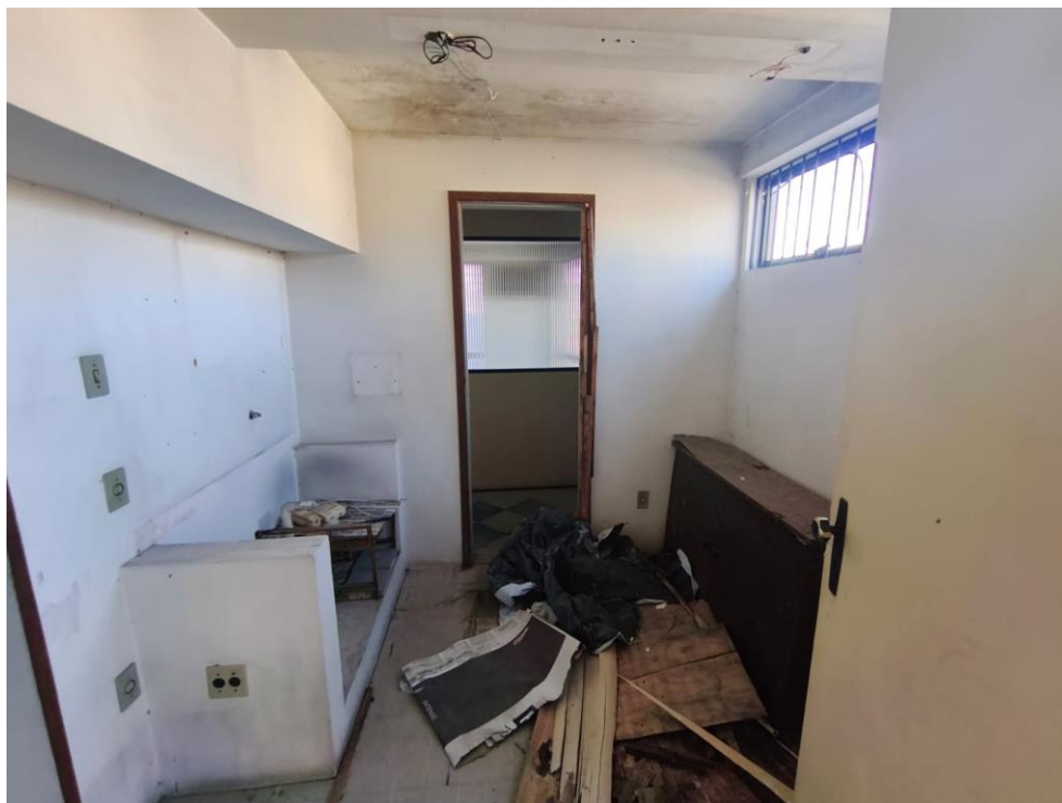
Foto 13: sala 201 - interna Fonte: Carvalho Lira Engenharia, 2026
