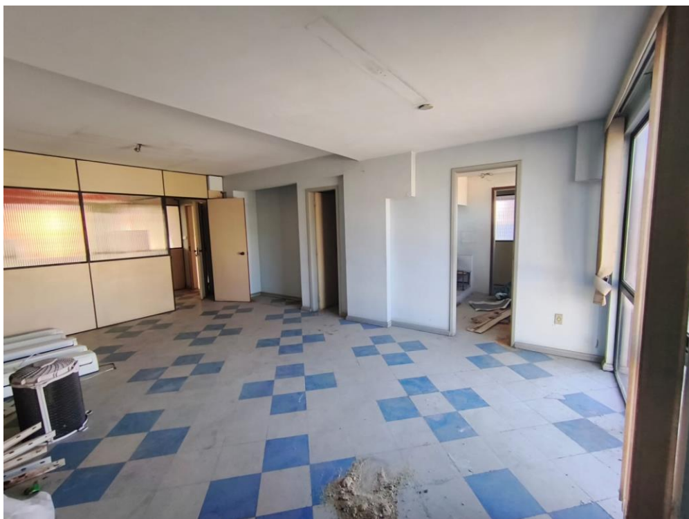
Foto 12: Sala 201 interna Fonte: Carvalho Lira Engenharia, 2026
